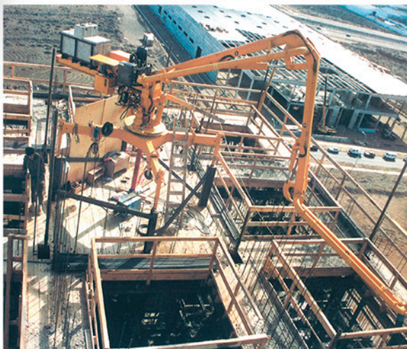
Brazo Distribución de Hormigón Tipo BEH-12.2/125
